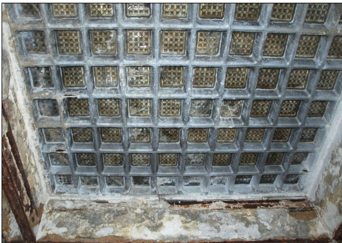
Karlovy Vary - Císařské lázně, provozní trakt, detail střešních světlíků s původními luxfery.
