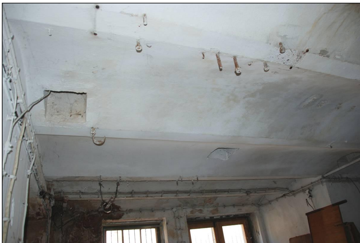
Karlovy Vary - Císařské lázně, Rašelinový pavilón - 1. NP – střední hala, detail násypných prostupu v klenbě a šroubových úchyty po pravoúhlých převodech hnací hřídeli.
