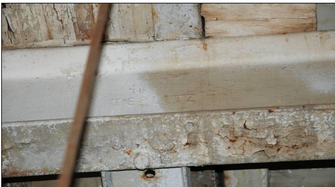
Karlovy Vary - Císařské lázně, provozní trakt, Rašelinový pavilón, válcovaný nosník s označením TEPLITZ
